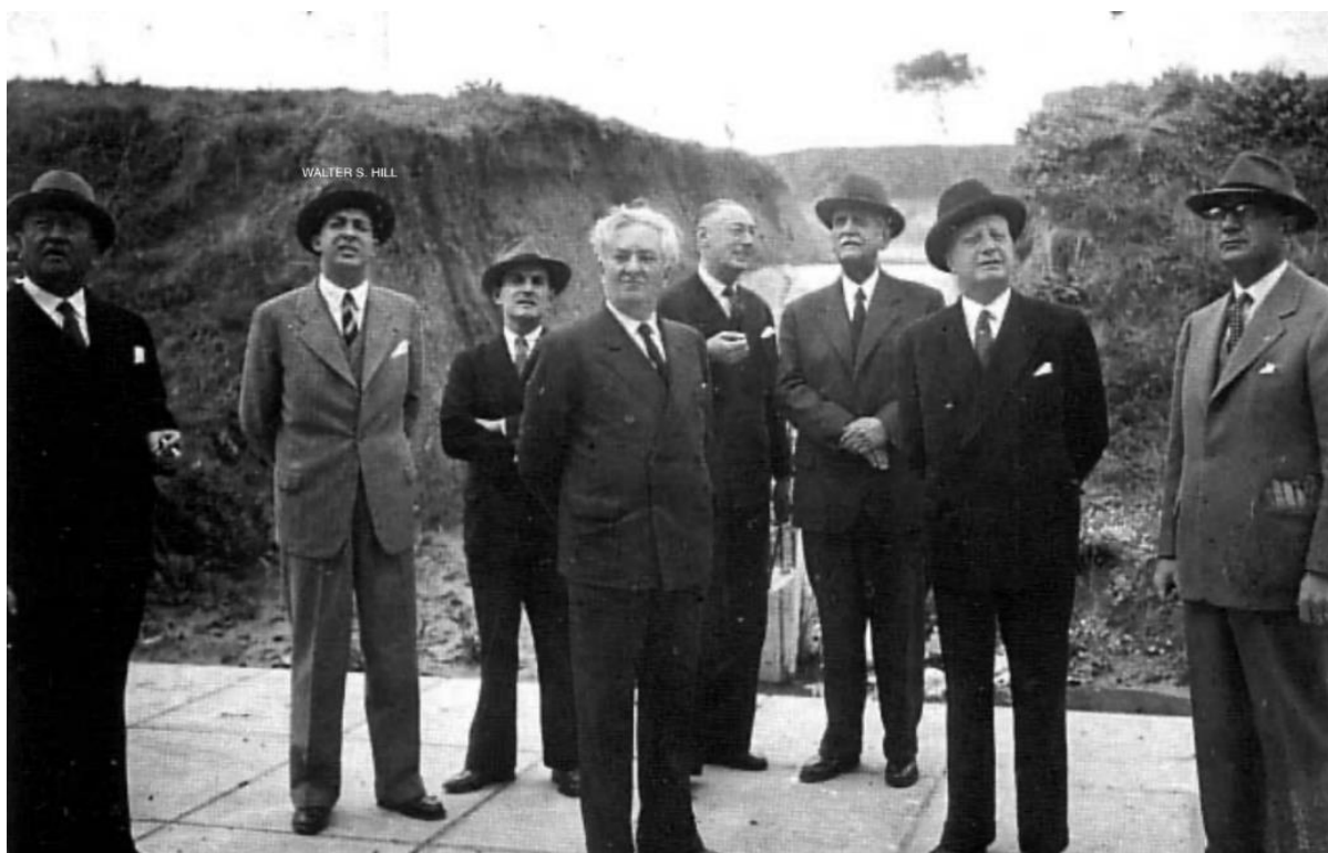
Figura 5 – Visita de delegación a las obras de la Facultad de Ingeniería
